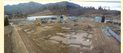
造成工事の様子
