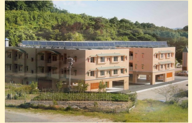
ケアハウス外観
