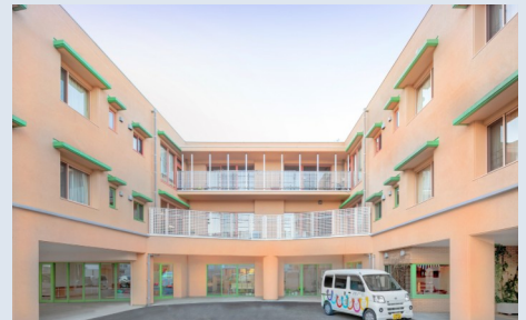
▲ケアハウス外観
